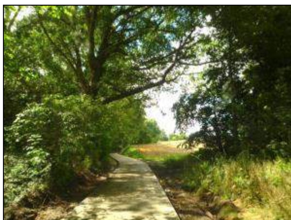
Aménagement cyclable en construction, Chemin de la Sucrierie
