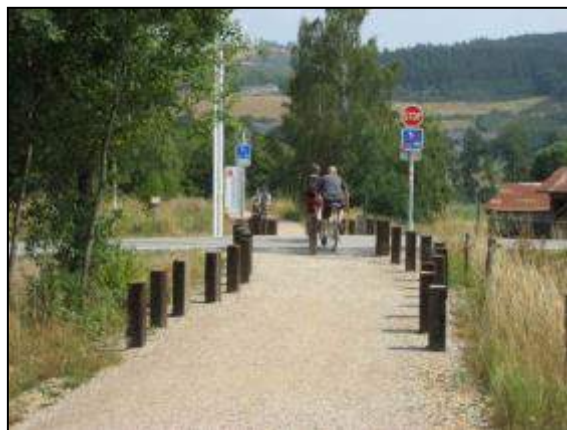
Exemple d'une mise en évidence d'une traversée de route
