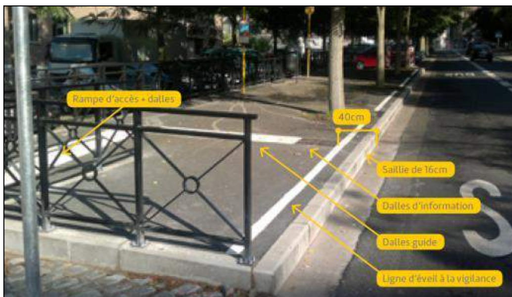
Figure 2 Exemple d'aménagement d'un arrêt conforme PMR
