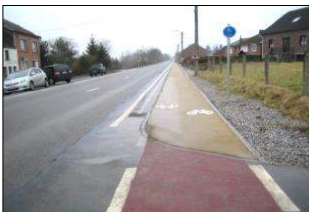
Piste cyclopiétonne bidirectionnelle D10 sans séparation, marquage rouge en traversée
