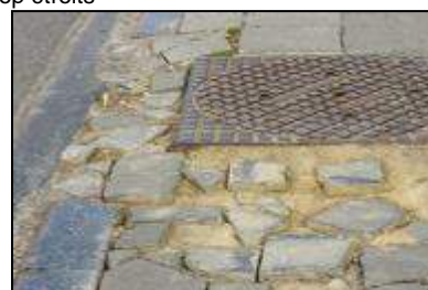
trottoir défoncé par le passage et le stationnement de véhicules
