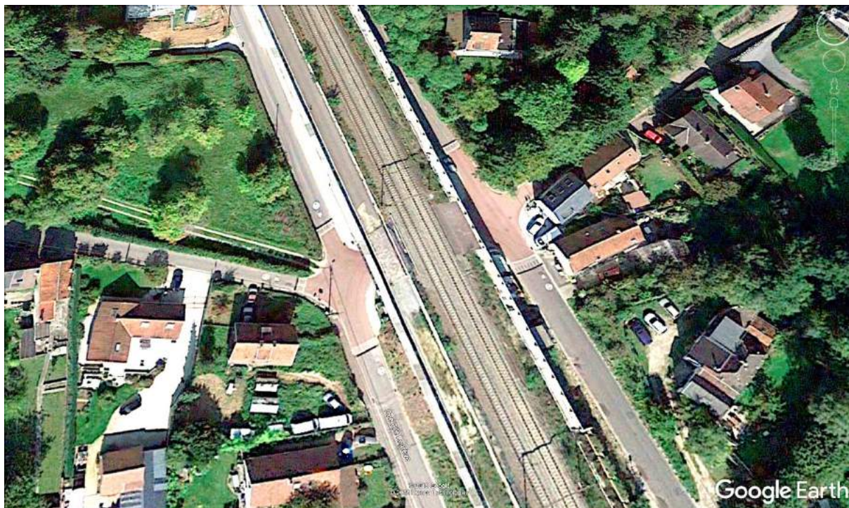
Figure 22 : vue aérienne Google Earth du passage sous voies
