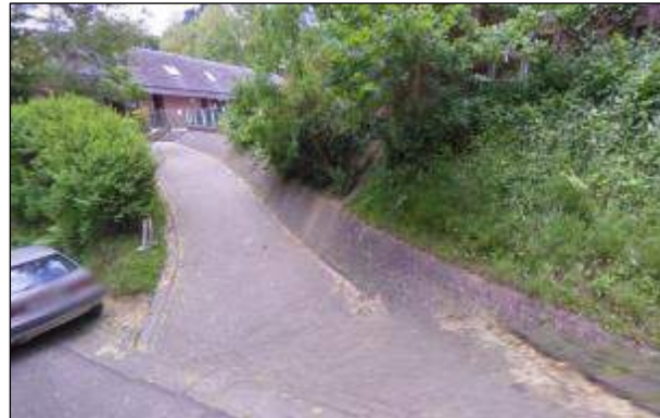
Entrée de la rampe
