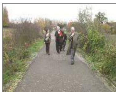
Gravier fin stabilisé au ciment
