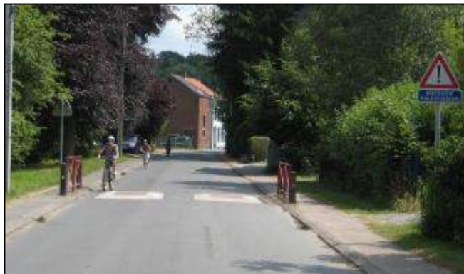
Les coussins permettent le passage de cyclistes
