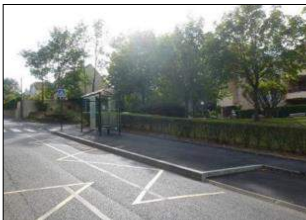
Exemple d'arrêt en avancée de trottoir
