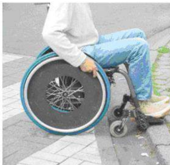
La chaise roulante ne peut pas franchir un ressaut de plus de 2 cm.
