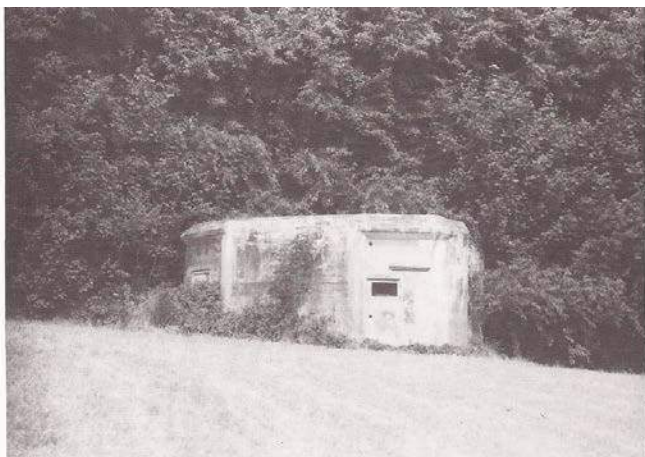
BL2 défendant les pentes vers la ligne de chemin de fer à Bierges.
